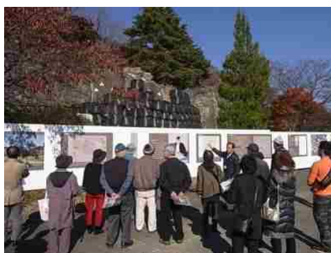
崩れた石垣を目の当たりにした小峰城
